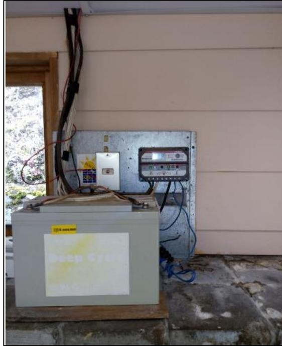
**Figura 1.2 Componentes de los SFV instalados**
