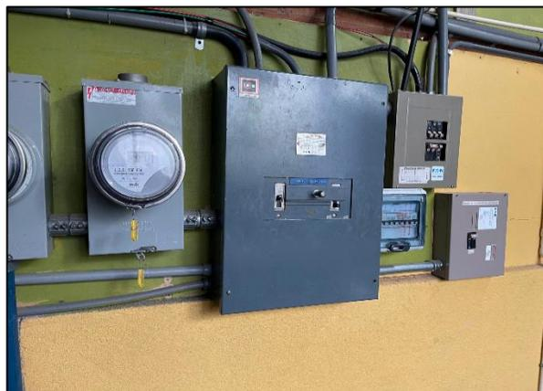
**Figura 4.23** Área de cuarto eléctrico. Transferencia de la planta hidroeléctrica y la planta Diésel.
