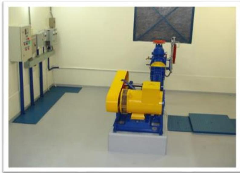
**Figura 4.11 Generador de la micro-central hidroeléctrica El Páramo-Chirripó.**
