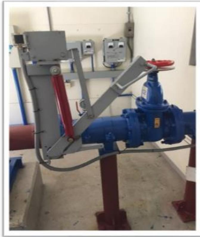
**Figura 4.14** Válvula de cierre de emergencia y válvula para el control del suministro de agua. Micro-central hidroeléctrica El Páramo-Chirripó.
