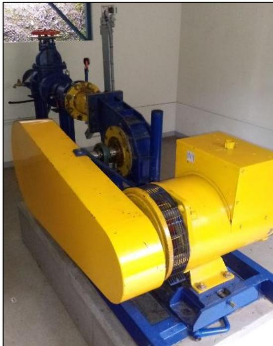
**Figura 1.4 Equipo electromecánico de la micro-central hidroeléctrica.**
