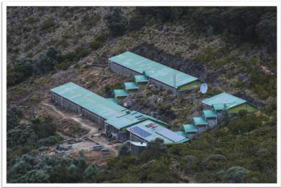
**Figura 4.3 Albergue Base Crestones donde se muestran los módulos fotovoltaicos, así como colectores solares.**
