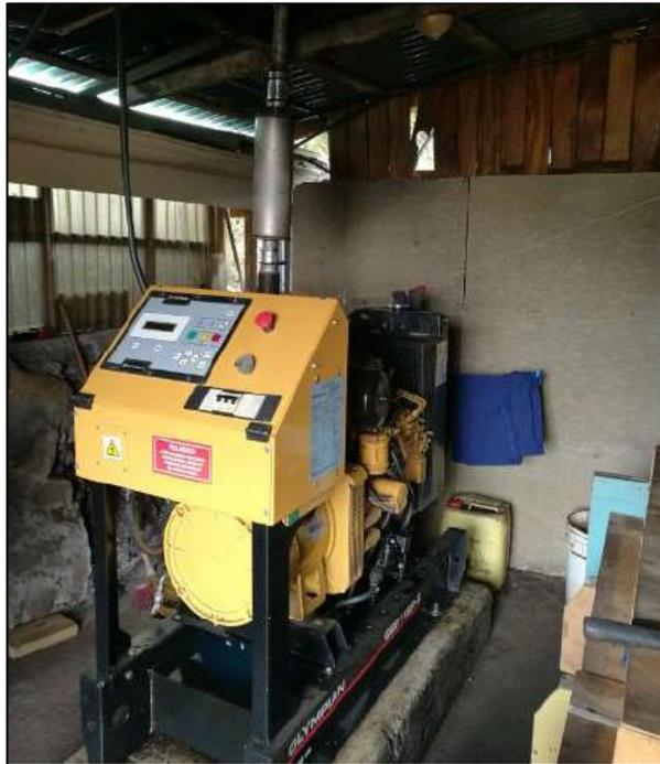
**Figura 1.5 Grupo electrógeno Diésel de 13 kW**
