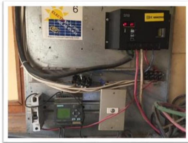
**Figura 4.7 Módulo Fotovoltaico con sistema de control tipo LOGO modelo 12RC, marca Siemens.**
