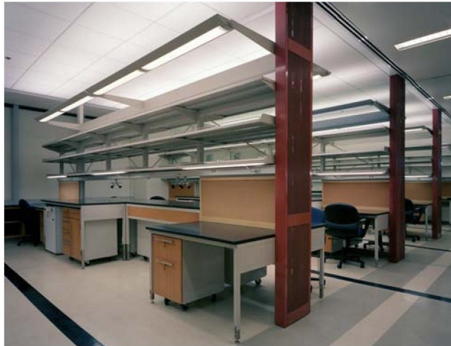
Figura 14. Técnica iluminación Laboratorio Luminaria Directa - Indirecta como capa tarea (Tomada de [16] Página 4)
