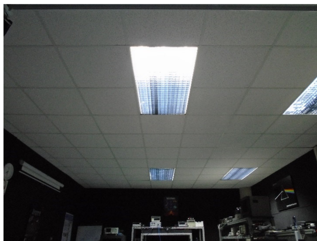
Figura 20. Fotografía de las luminarias existentes en los laboratorios LAFTLA. (Confección propia)
