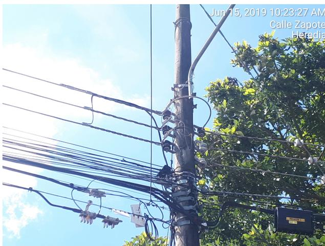
Figura 3.15: Conexión de neutro únicamente.
