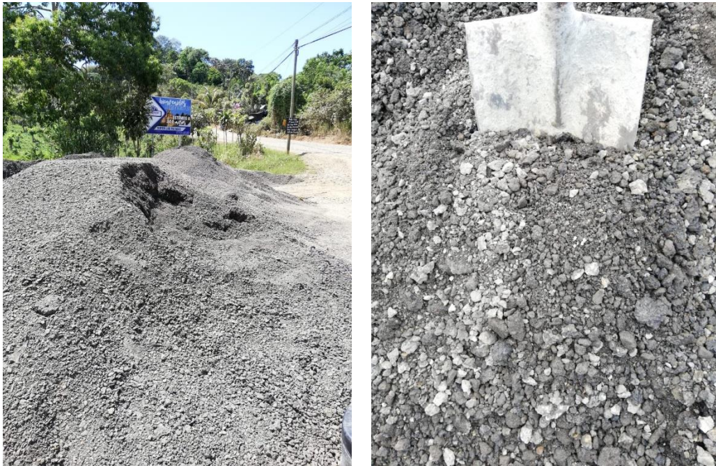
Figura 3. Primer muestreo de material asfáltico perfilado
