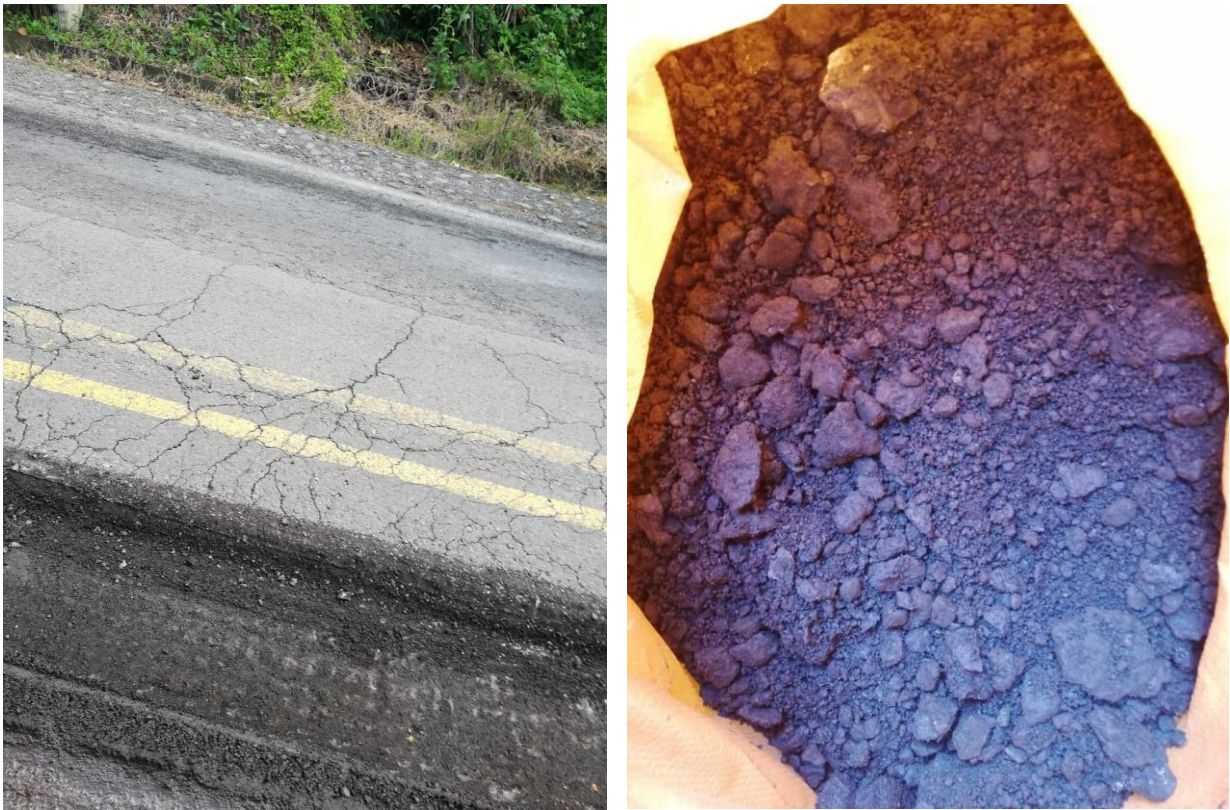
Figura 5. Segundo muestreo de material asfáltico perfilado
