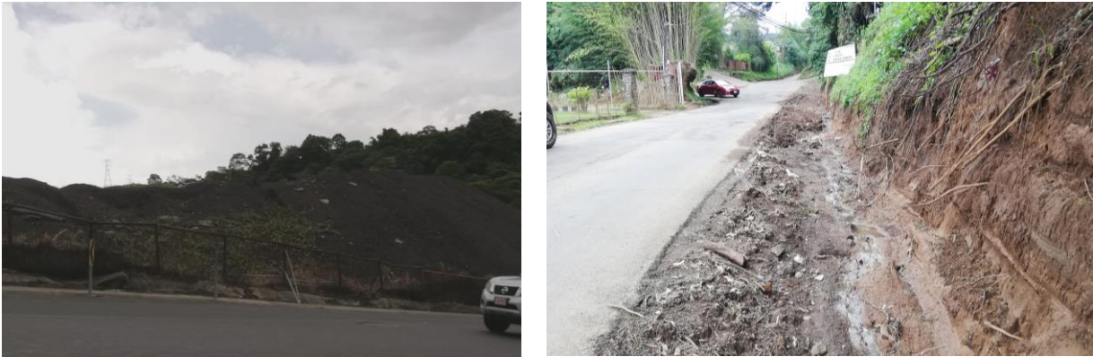
Figura 7. Tercer muestreo de material asfáltico perfilado y zona de colocación del material
