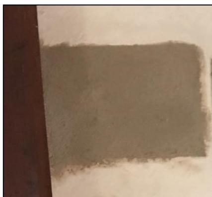
Figura 27. Ilustración ejemplo de resultado inmediato de pared sellada con mortero de cal y arena
