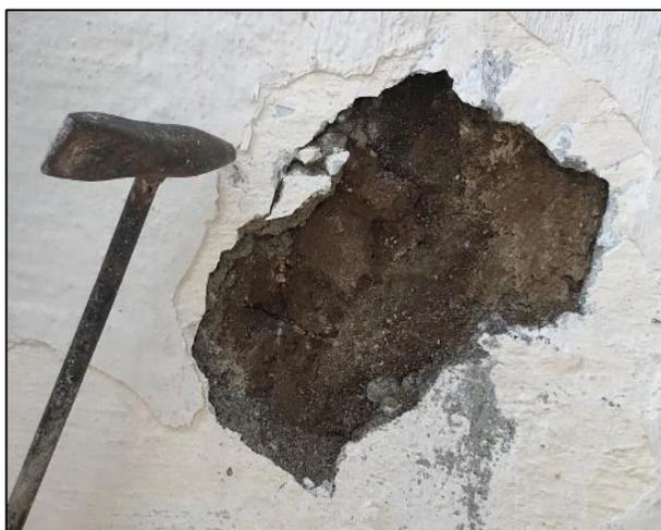
Figura 26. Ilustración de apertura de ventanas de inspección.
