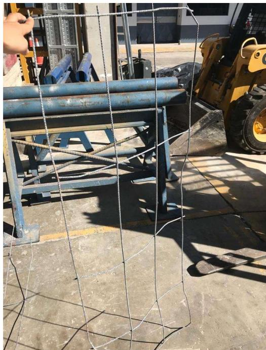
Figura 6. Refuerzo baldosas prefabricadas
