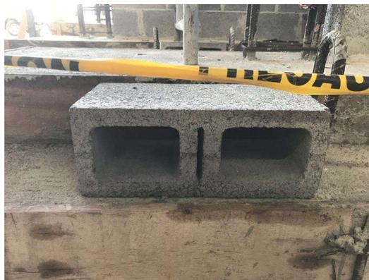
Figura 4. Bloques utilizados en la pared de mampostería
