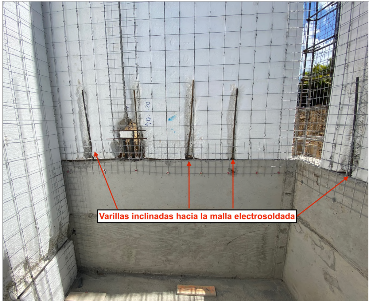
Figura 65. Ejemplo 3 de instalación incorrecta de paredes tipo electro panel Fuente: Elaboración propia
