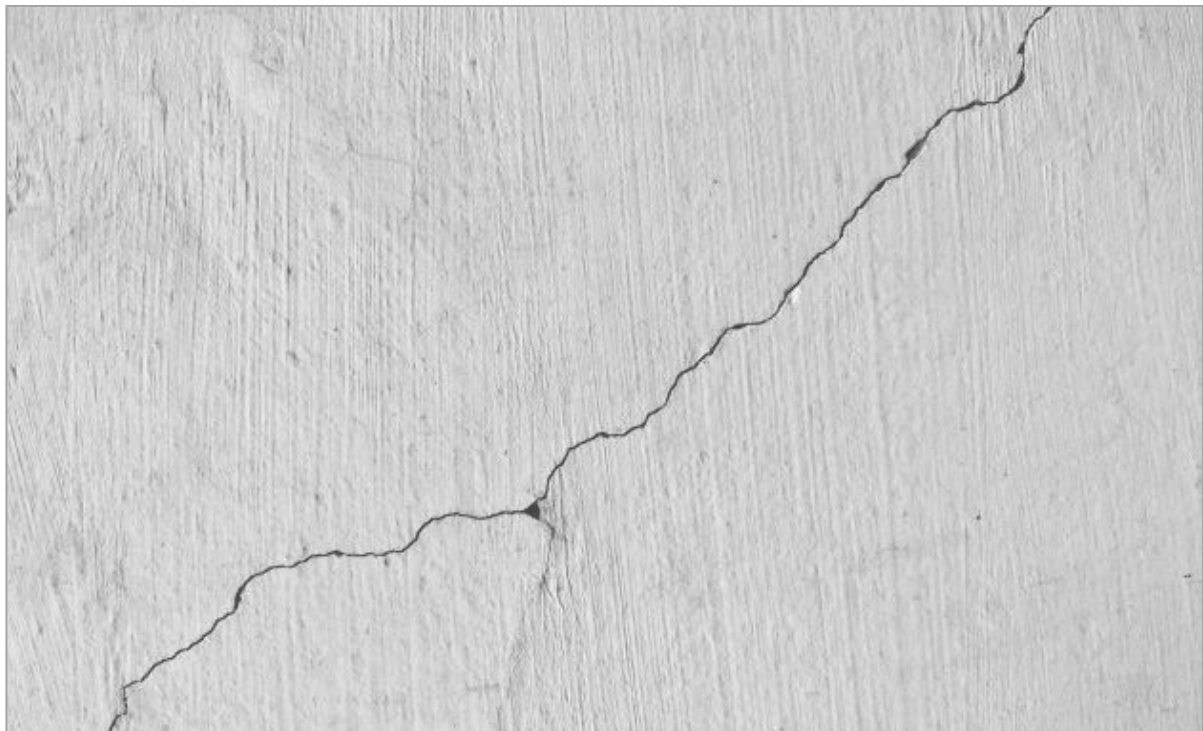
Figura 21. Ejemplo de fisura por sobrecarga Fuente: Martínez, 2020
