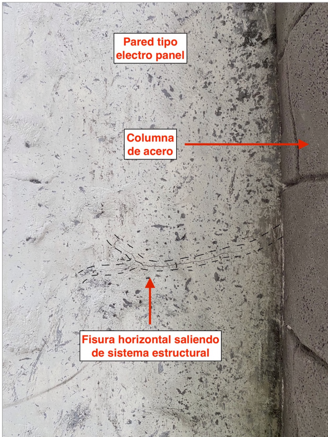
Figura 38. Muestra 3 de daño tipo HE dentro de los objetos de estudio Fuente: Elaboración propia
