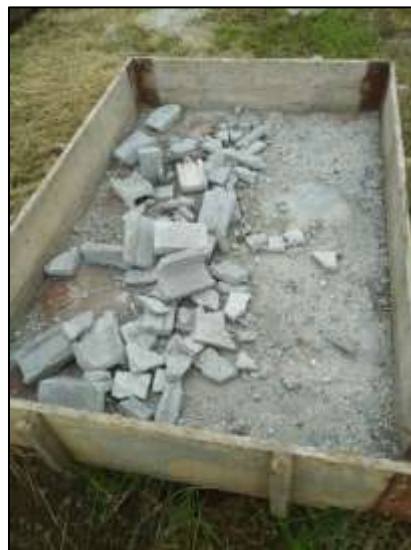
Figura 26. Separación de residuos de block del escombro.
