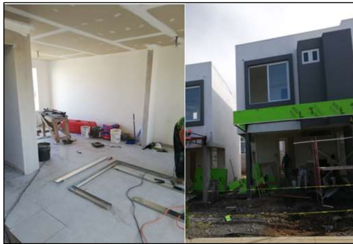
Figura 19. Uso de estructura liviana en los proyectos 2B y 1A, respectivamente.
