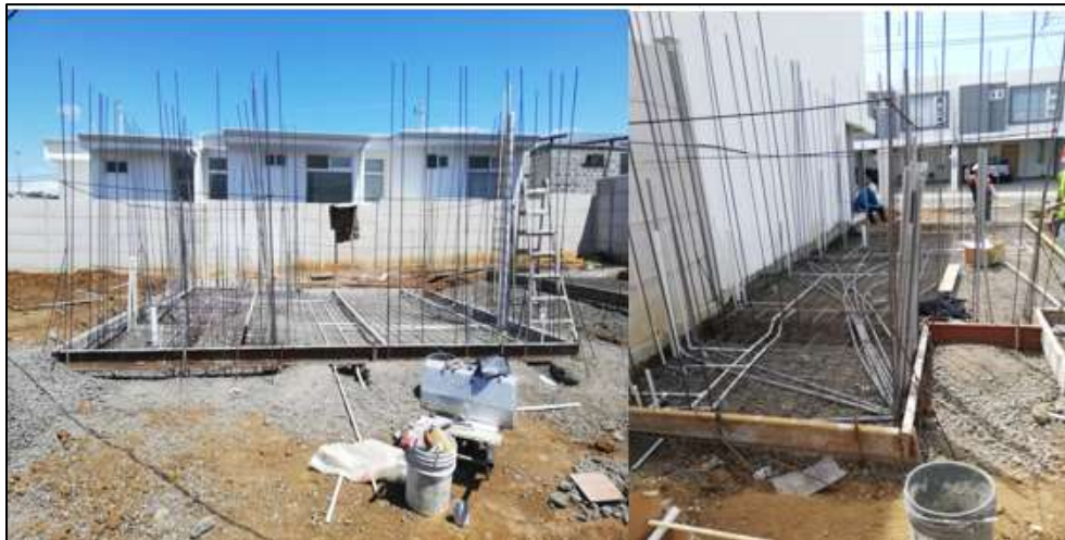
Figura 13. Losa flotante proyectos 1B y 1A, respectivamente.
