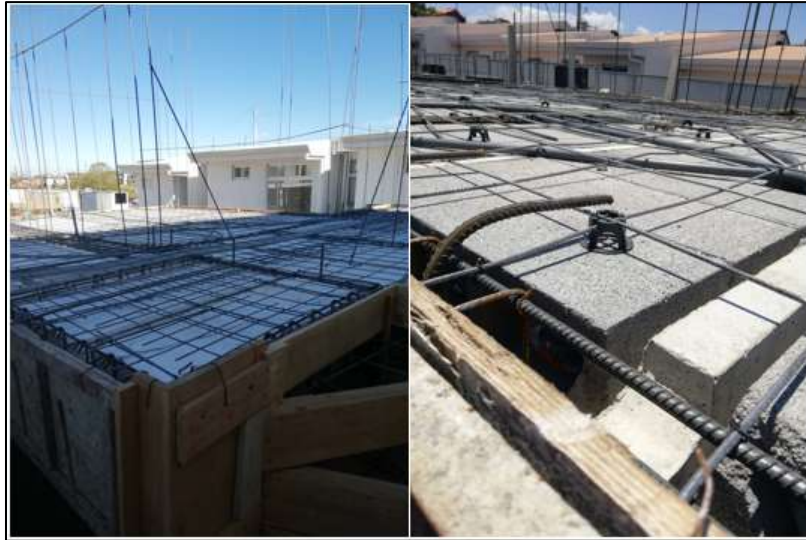
Figura 15. Sistema de entepiso empresa A y empresa B, respectivamente.
