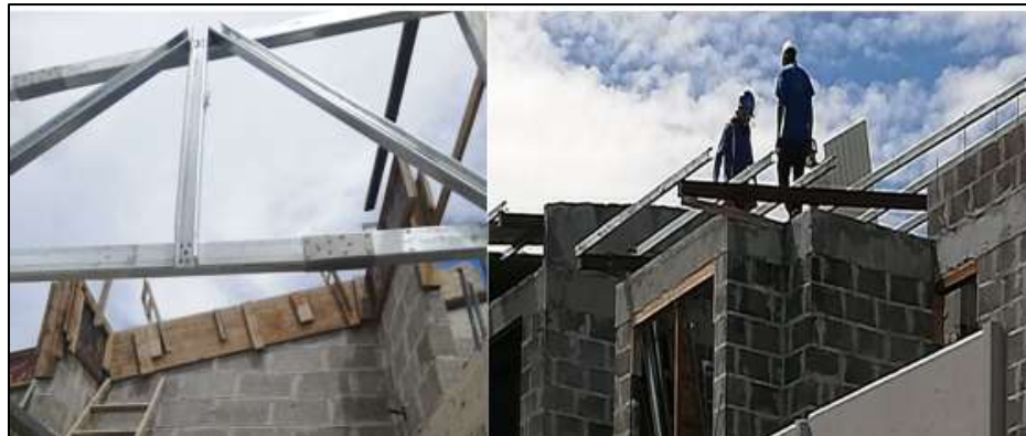
Figura 18. Estructura de techos proyecto 1B y 2A, respectivamente.
