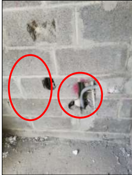
Figura 27. Cortes en pared de mampostería para colocación de tubería, proyecto 1A.
