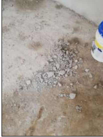
Figura 32. Restos de repello empresa A.
