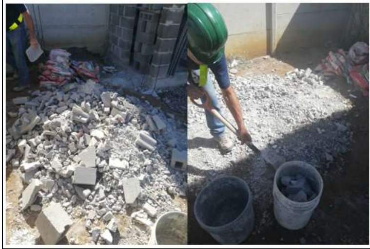
Figura 25. Separación de residuos de block del escombro.
