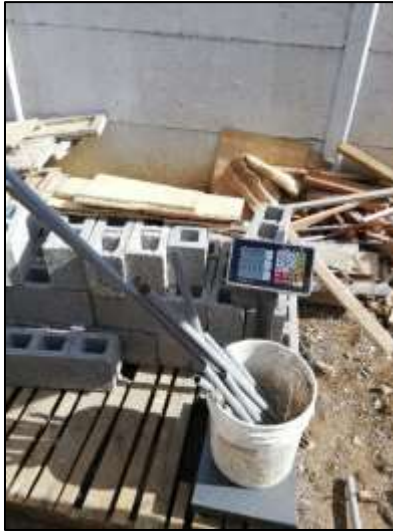
Figura 34. Tubería eléctrica proyecto 1A.
