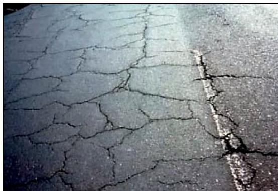
Figura 6. Grietas transversales a causa del TDC
