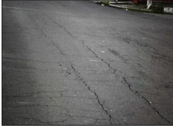
Figura 5. Grietas longitudinales en el pavimento a causa del DTC
