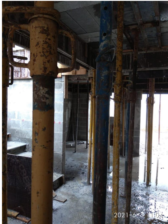
Figura 23. Imagen real de los puntales de la vivienda en etapa de colado de entrepiso
