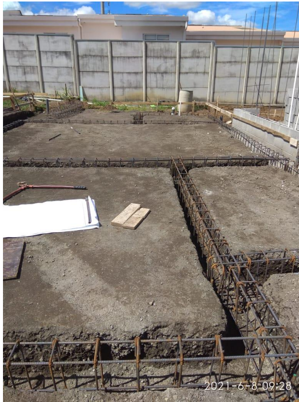
Figura 25. Imagen real de la etapa de colocación de acero de las cimentaciones
