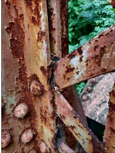
Figura 42. Laminación en elemento vertical en unión con placas y demás elementos de la unión.
