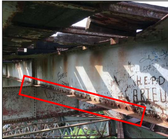
Figura 35. Corrosión (rojo) en las alas de los largueros del puente.
