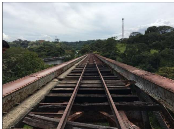
Figura 17. Vista a lo largo de la línea de centro del puente.
