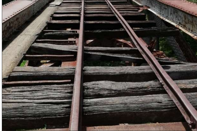
Figura 31. Estado de los durmientes de madera del puente.
