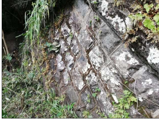
Figura 49. Pila sobre la cual se encuentra el apoyo fijo Norte del sector Oeste.
