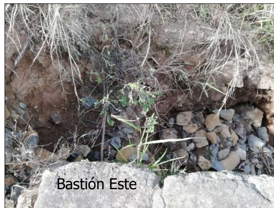
Figura 21. Erosión en el talud Sur del bastión Este
