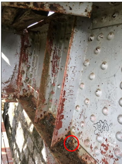
Figura 36. Corrosión y pérdida (rojo) de remaches en la viga de piso de la sección sobre el bastión Oeste.
