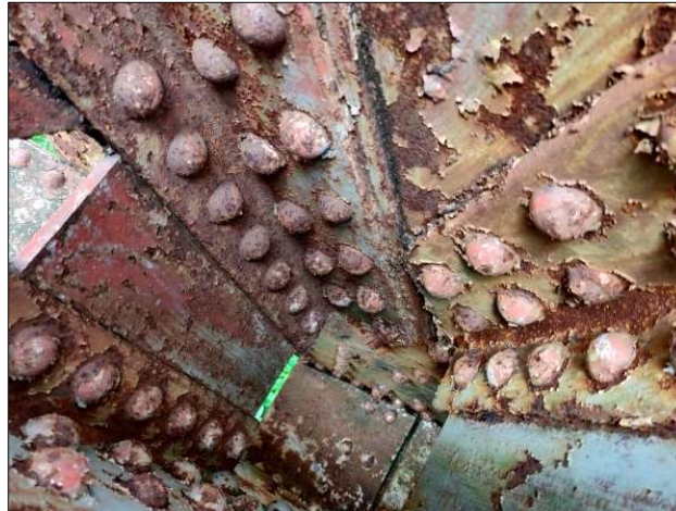
Figura 43. Laminación y corrosión en nodos inferiores de las cerchas.
