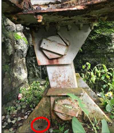
Figura 46. Apoyo con corrosión, falta de pintura, falta de pernos de unión (rojo) e inclinación.
