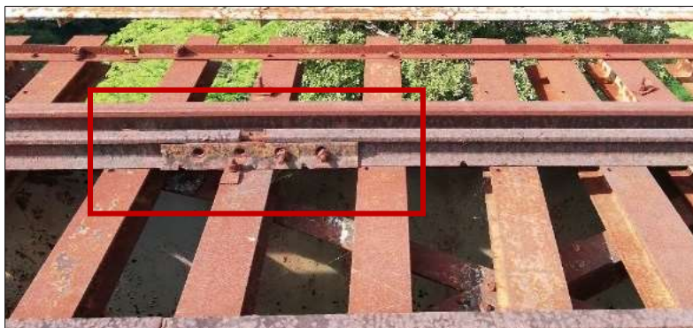
Figura 28. Estado de los rieles, eclisas y fijaciones del tablero del puente.
