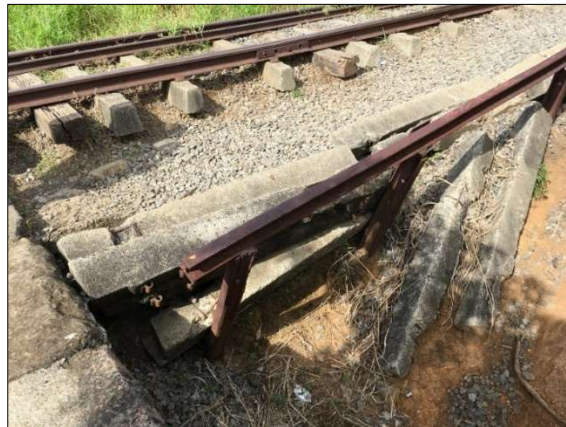
Figura 24. Manejo del talud de vía en el acceso Oeste del puente.
