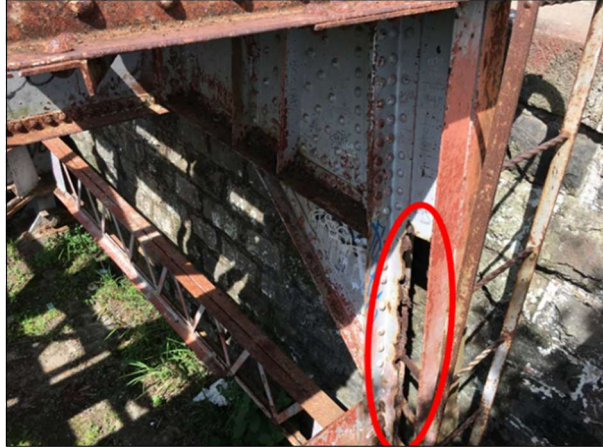
Figura 39. Estado precario (rojo) del elemento vertical Norte de la sección 0 del puente, en el bastión Oeste.
