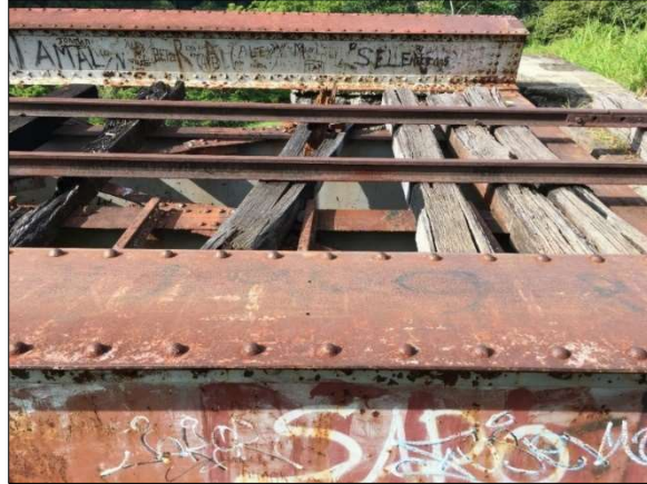
Figura 23. Elementos quemados, con grafiti, faltantes y golpeados.
