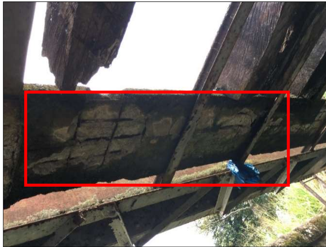
Figura 33. Acero de refuerzo expuesto (rojo) en la acera peatonal del puente.
