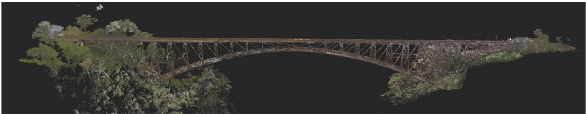
Figura 51. Vista de perfil de la nube de puntos a partir del escaneo láser.
