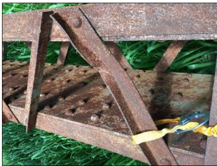
Figura 38. Daño por vandalismo o accidente en el arriostramiento interno de la cuerda inferior.
