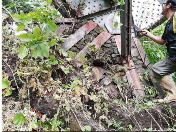
Figura 48. Apoyo fijo de la cercha Norte en el sector Oeste.
