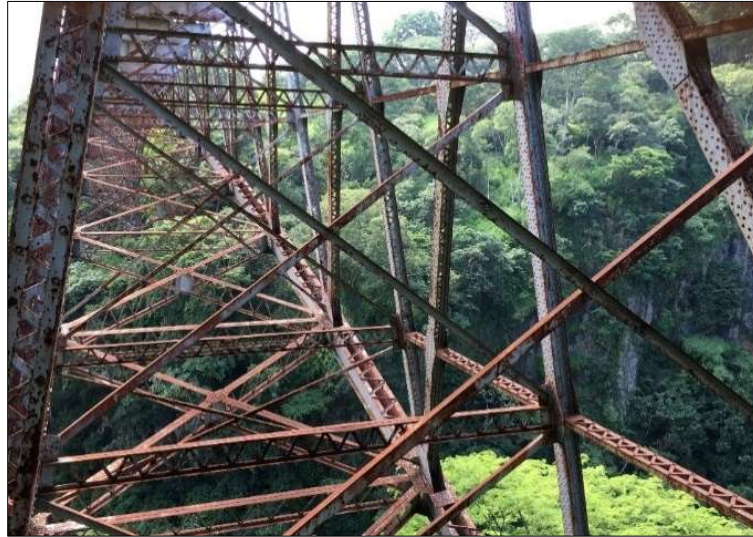
Figura 44. Estado del sistema de arriostramiento interno del puente.
