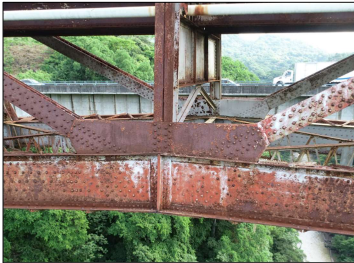
Figura 41. Corrosión en lámina de unión de los nodos de las cerchas.
