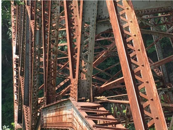
Figura 40. Elementos diagonales de la estructura.
