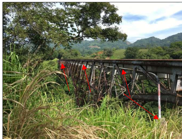
Figura 22. Tubería, de gasolina, adherida a la estructura del puente
