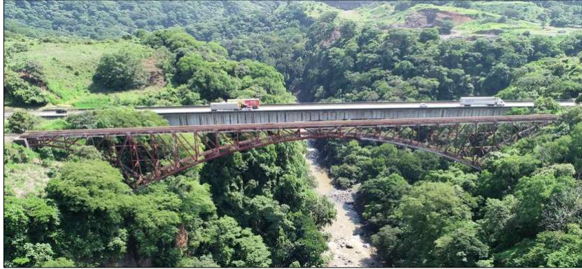
Figura 18. Vista lateral Norte del puente.
