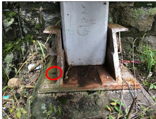
Figura 47. Apoyo con falta de perno de unión (rojo) y acumulación de escombros.
