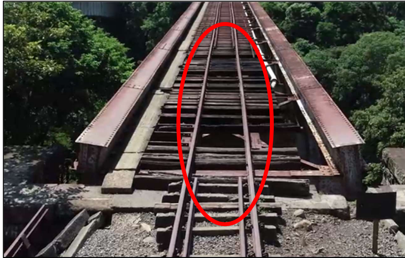
Figura 29. Falta de guardarrieles (marcado en rojo) necesarios en acceso Oeste al puente.
