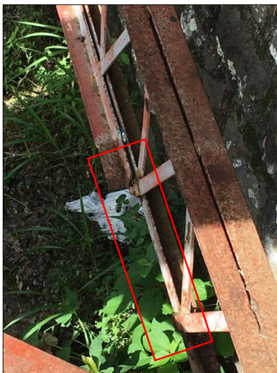
Figura 45. Pérdida de sección (rojo) en elementos del arriostramiento inferior.
