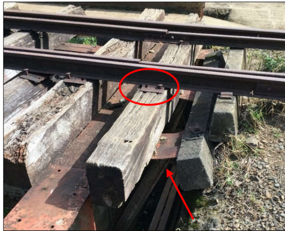
Figura 25. Elementos entre el bastión y la estructura sin ningún tipo de fijación.
