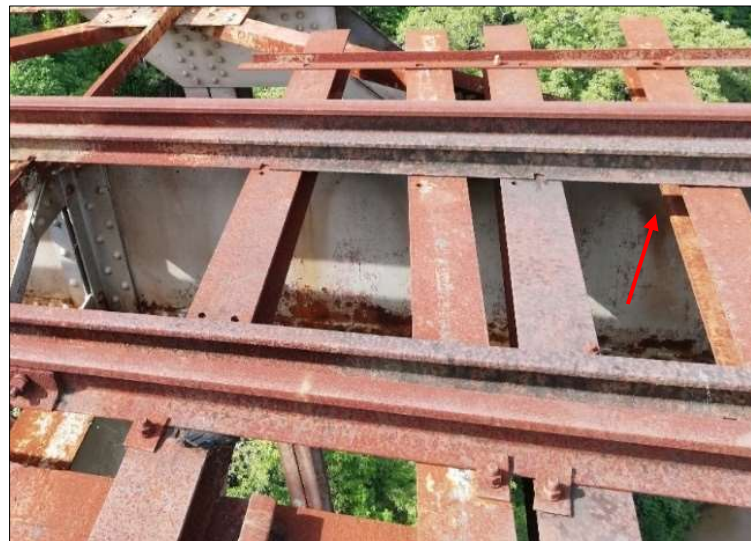
Figura 32. Estado general de los durmientes de acero del puente.
