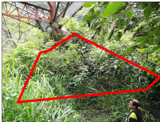
Figura 50. Condición de vegetación en la pila (rojo) sobre la cual se encuentra el apoyo Sur del sector Oeste.
