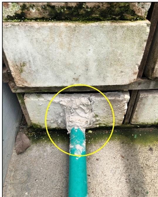
**Figura 143.** Reparación realizada en la tubería de salida de la torre 1
