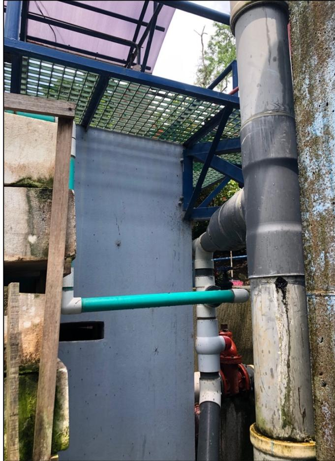
**Figura 14.** Conexión del UASB al Keisya y filtro percolador
