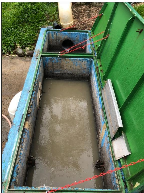
**Figura 24.** Estructura del desarenador
