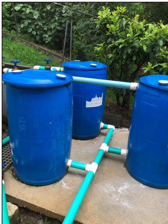
**Figura 34.** Filtro de carbón activado
