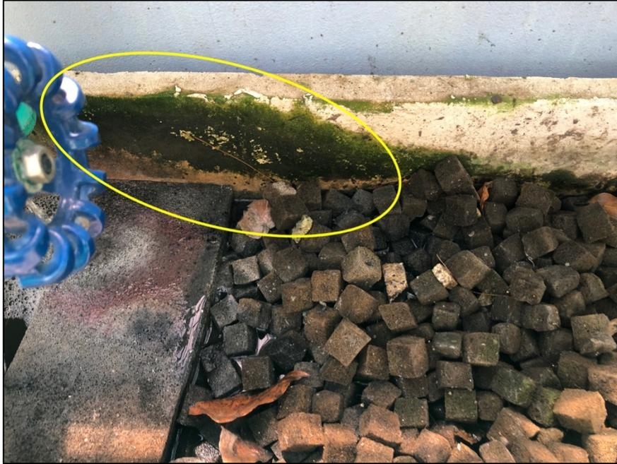
**Figura 145.** Afectación de la humedad en la estructura del Keisya
