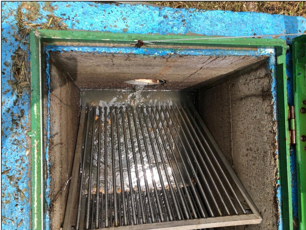
**Figura 59.** Punto 1 de muestreo: Caja de rejillas
