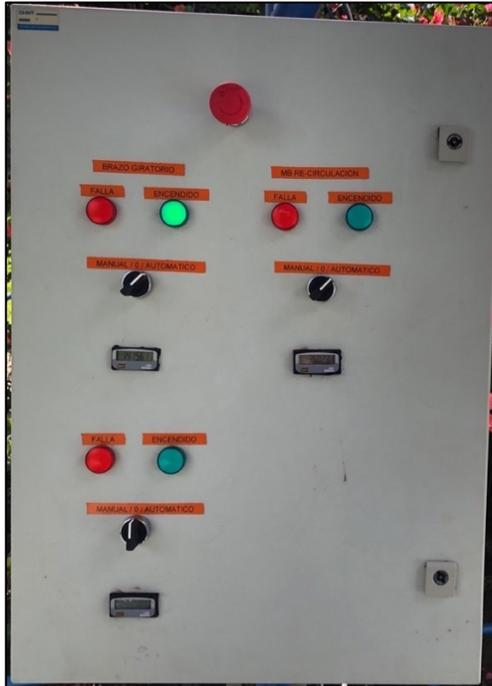
**Figura 31.** Panel de control del filtro percolador
