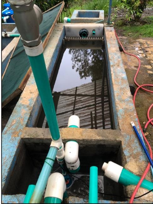
**Figura 32.** Sedimentador secundario
