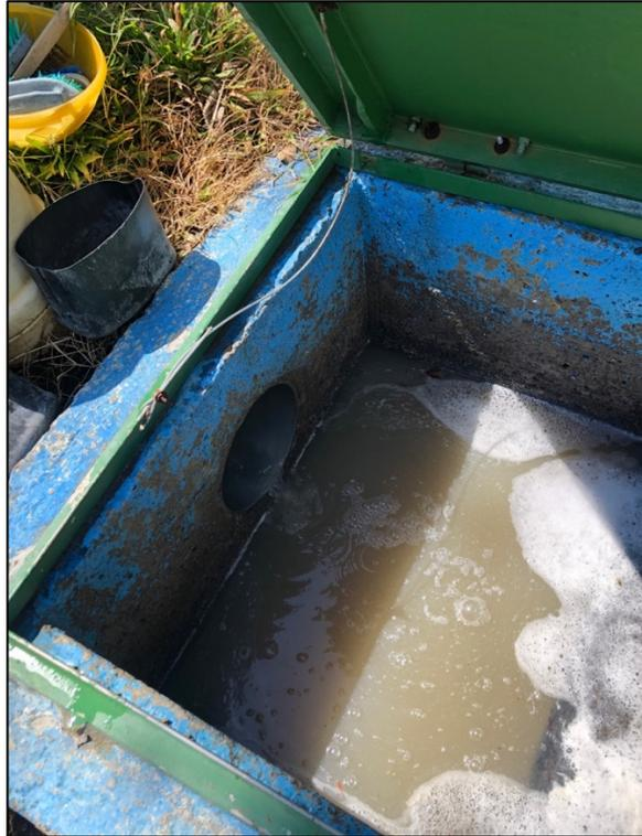
**Figura 25.** Entrada de las aguas residuales al desarenador
