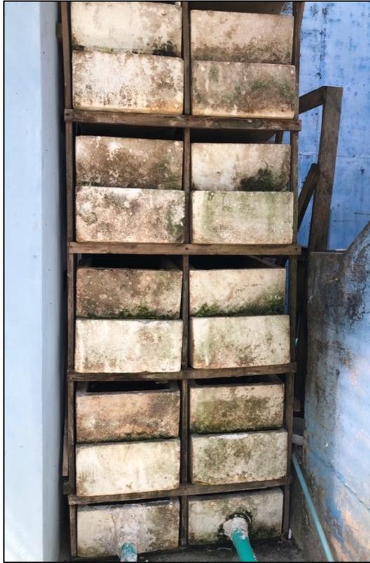
**Figura 8.** Estructura del filtro biológico Keisya
