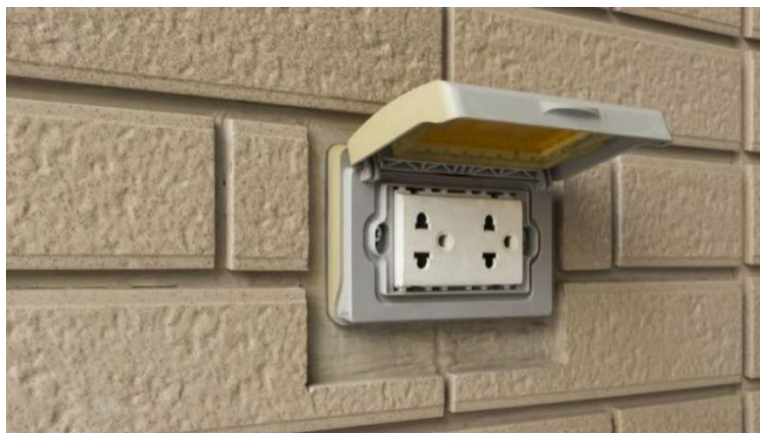
Figura 15. Tomacorriente externo Fuente: Elaboración propia, 2021
