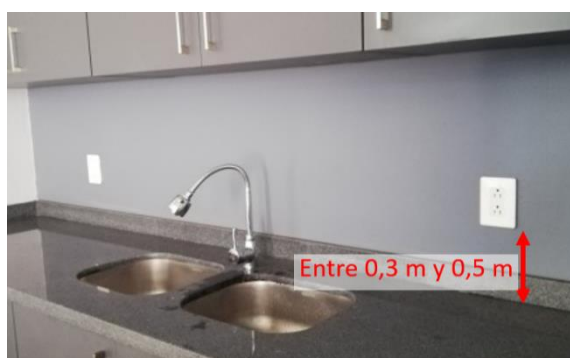
Figura 14. Altura de tomacorrientes sobre mesón de cocina Fuente: Elaboración propia, 2021
