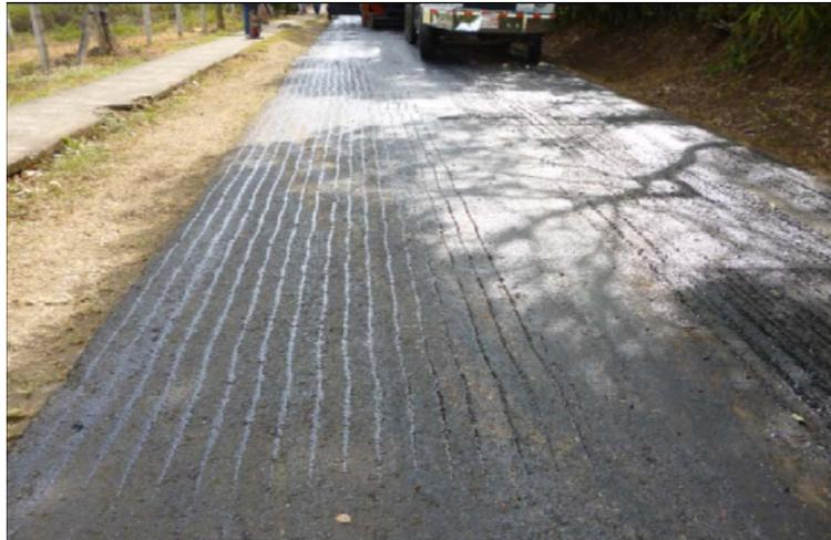
Figura 17. Riego de liga no uniforme en la totalidad de superficie a intervenir.
