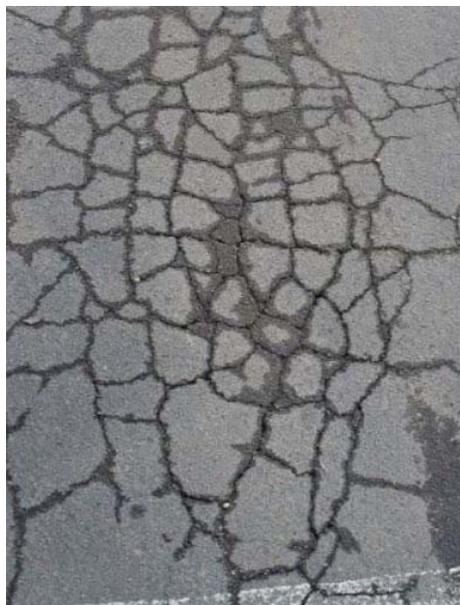
Figura 16. Agrietamientos por fatiga.
