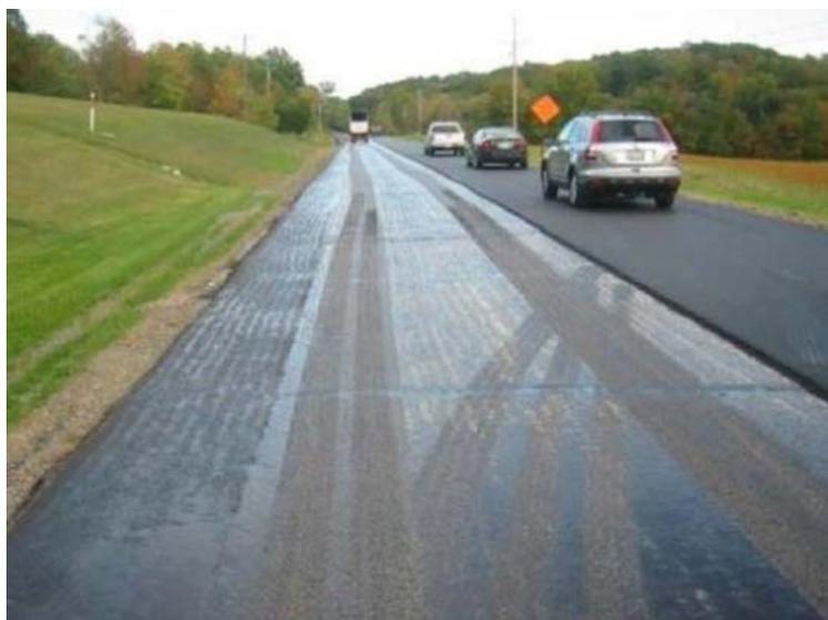
Figura 20. Arrastre de riego de liga debido al tránsito de vehículos sobre la emulsión
