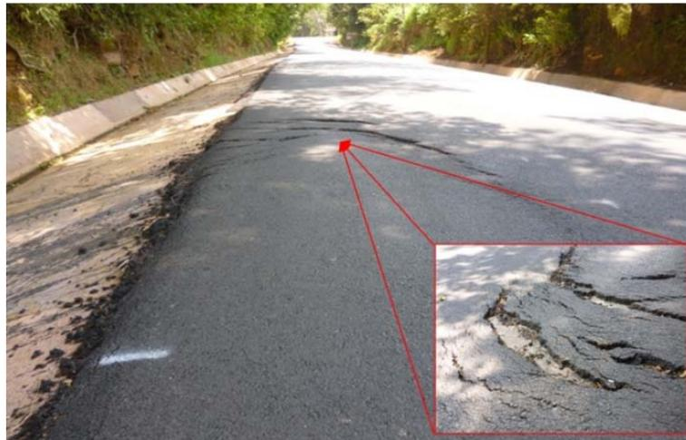
Figura 15. Delaminación por desplazamiento de la mezcla asfáltica, Ruta 712, Costa Rica.
