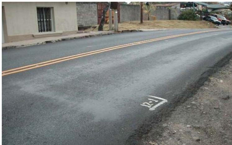
Figura 19. Exudación en superficie de rodamiento
