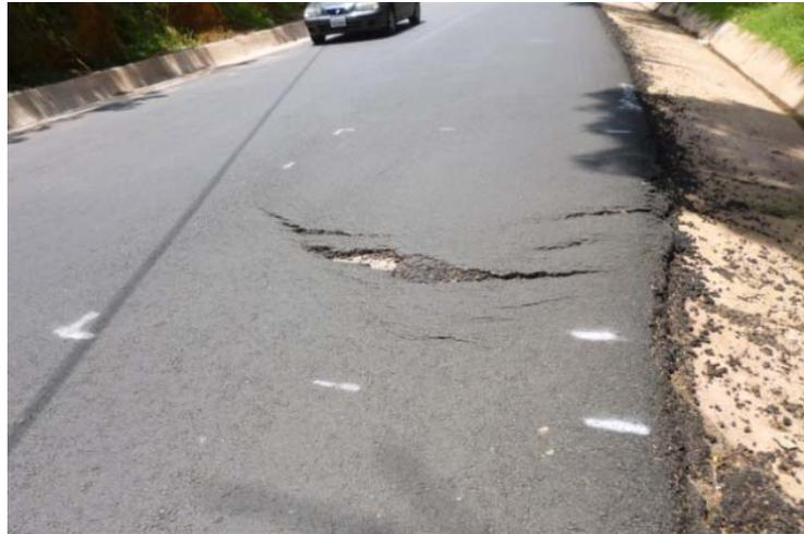
Figura 14. Desplazamiento de mezcla asfáltica, Ruta 712, Costa Rica.
