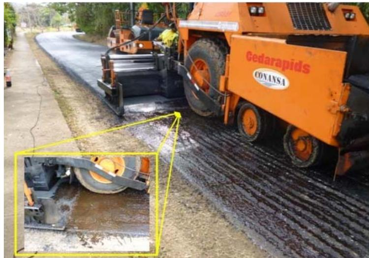
Figura 18. Exceso de emulsión asfáltica en junta transversal con carpeta recién colocada.
