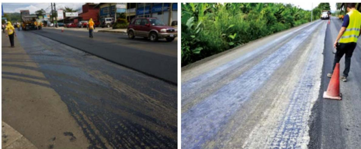
Figura 1. Arrastre del riego de liga en las llantas de las vagonetas, durante el proceso de colocación de la capa asfáltica.
