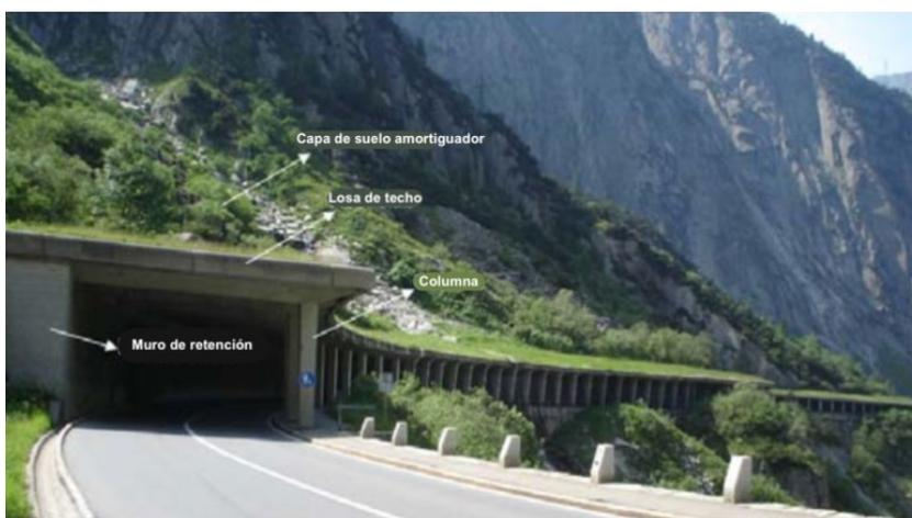
Figura 11. Túnel falso en Suiza, Galería Tanzenbein, Schoellenen, Gotthard Pass
