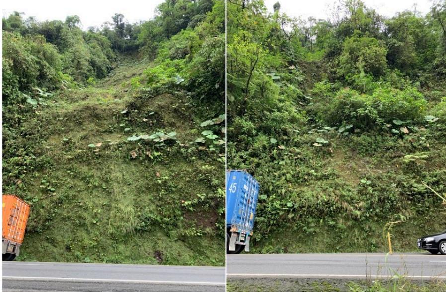
Figura 63. Secciones deslizadas del tramo 21+440 - 21+680
