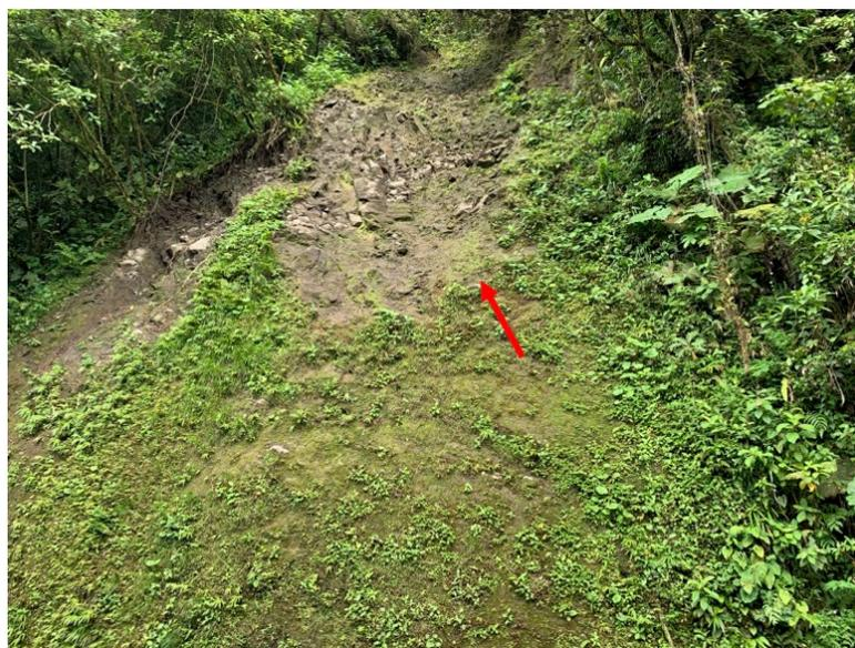
Figura 37. Roca fracturada en la parte superior del talud, zona 4
