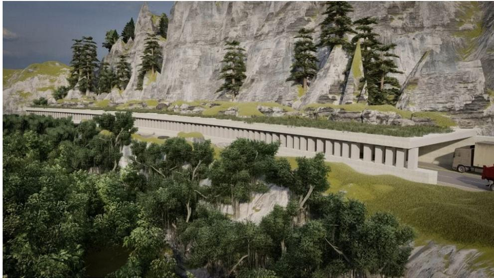
Figura 98. Modelo de túnel falso para el tramo 21+440 - 21+680 de la RN-32, vista Limón-San José
