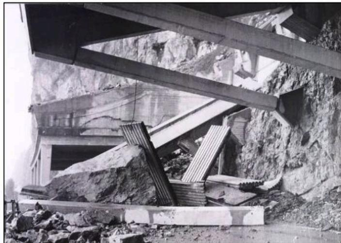
Figura 13. Túnel falso destruido por caída de rocas (500-600 m<sup>3</sup>), 1970
