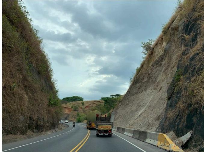
Figura 49. Estado del talud km 41+000, marzo 2021
