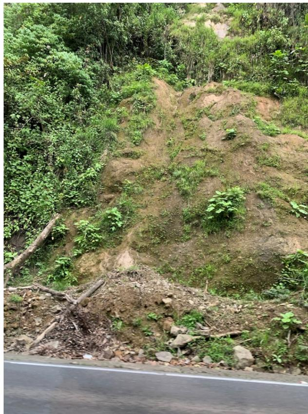
Figura 36. Escombros de deslizamiento en zona 4
