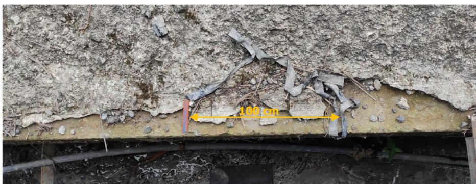
**Figura 74.** Desprendimiento de material en la base del talud
