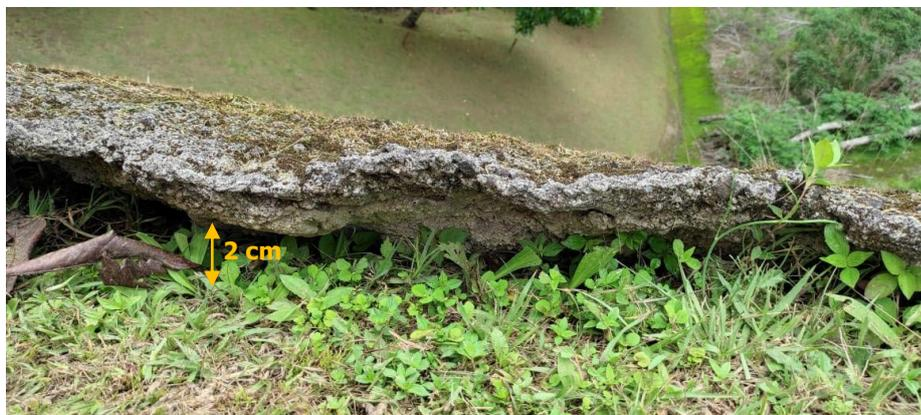
**Figura 53.** Lavado de material en el extremo superior del talud
