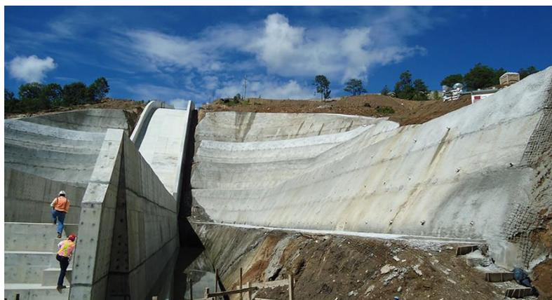
**Figura 5.** Recubrimiento de taludes
