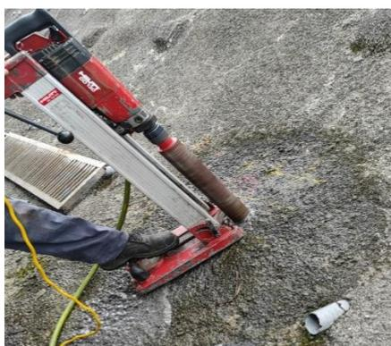
**Figura 66.** Proceso de extracción de los núcleos
