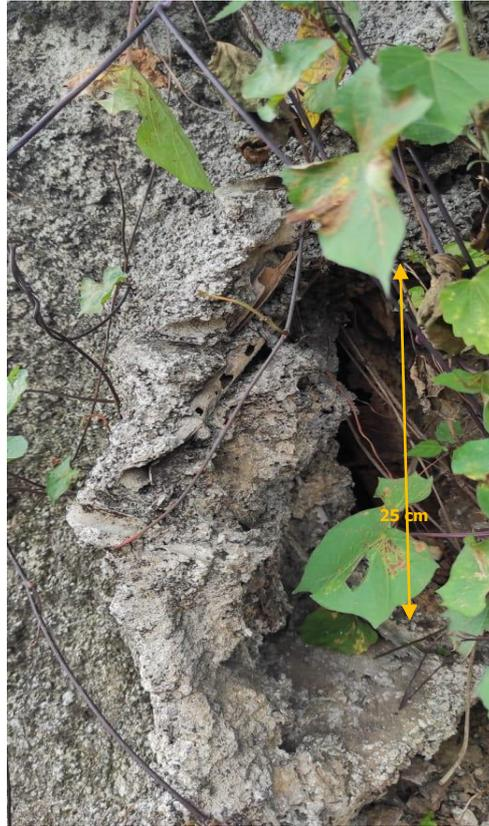
**Figura 63.** Suelo lavado en un extremo del talud
