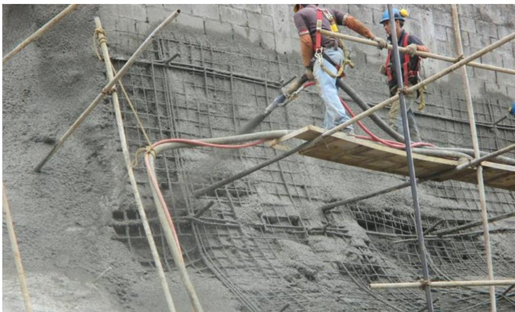
**Figura 24.** Proceso del lanzado de concreto sobre la malla electrosoldada
