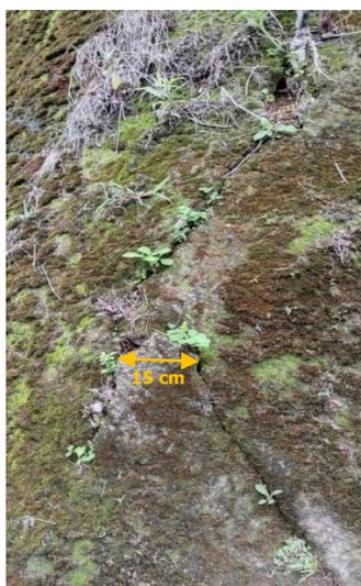
**Figura 51.** Fisuras de diferentes aberturas, con material orgánico
