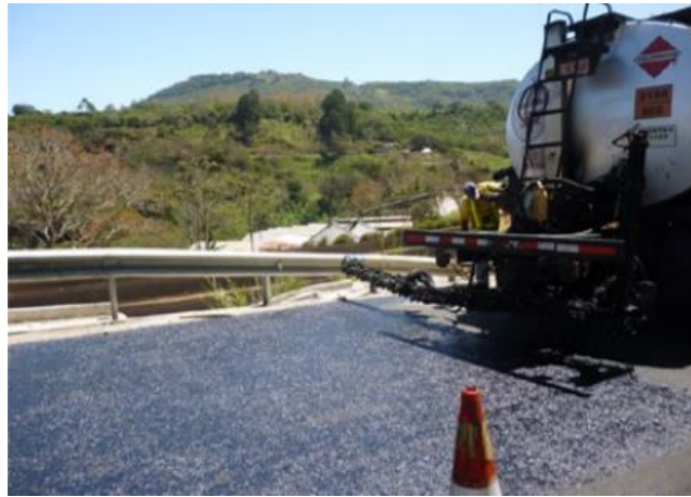
Figura 19. Aplicación uniforme del riego de liga
