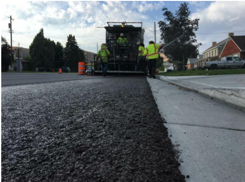
Figura 17. Aplicación de sellos asfálticos
