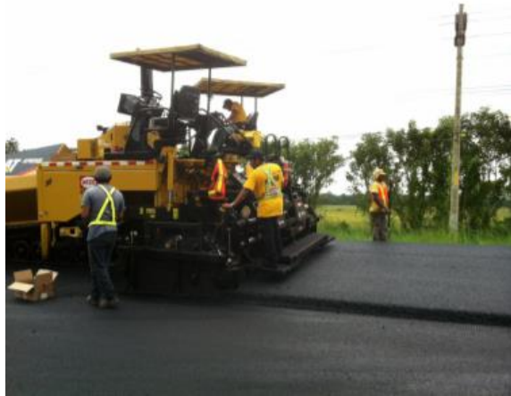
Figura 24. Colocación de la sobrecapa asfáltica
