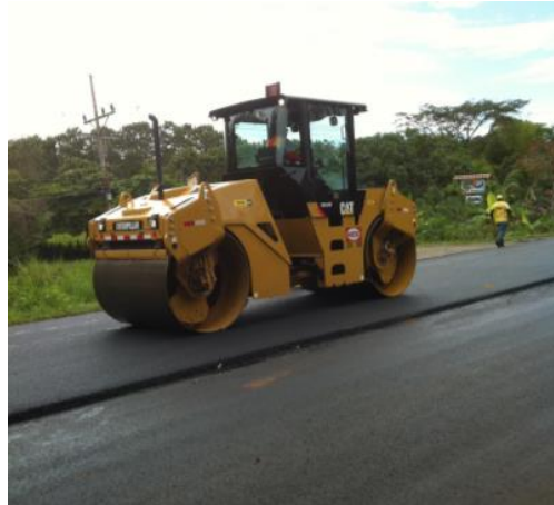
Figura 25. Compactación de sobrecapa asfáltica mediante compactador de tambor
