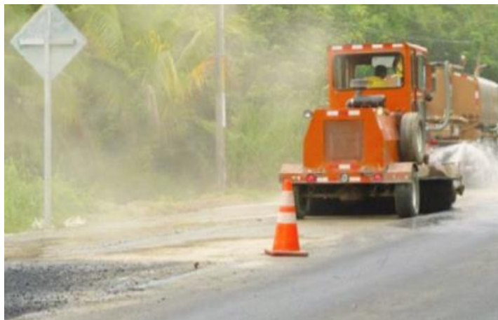
Figura 18. Limpieza de superficie mediante barredora mecánica
