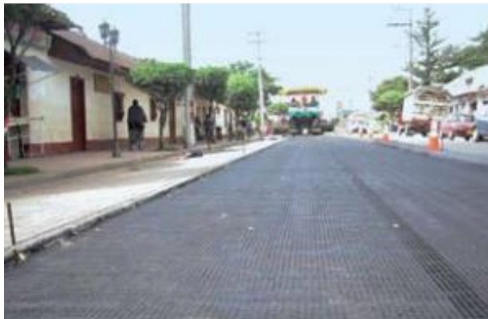
Figura 11. Uso de geomalla de vidrio en recarpeteo de pavimentos flexible
