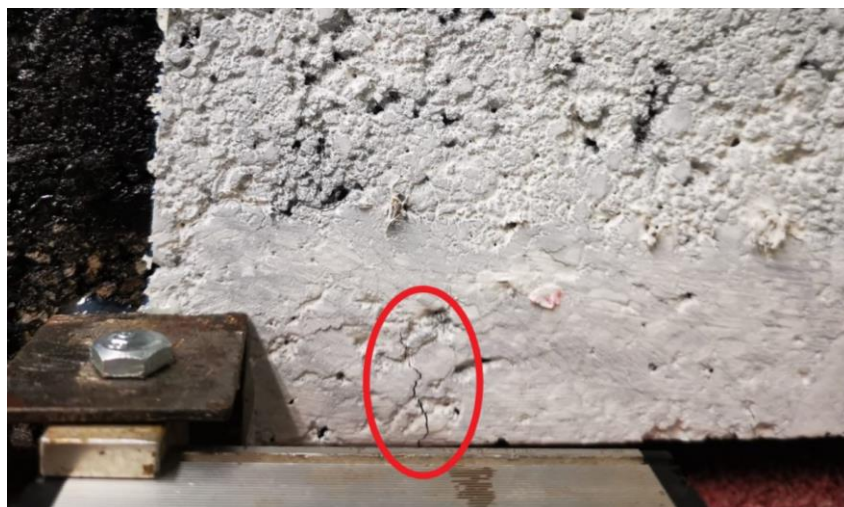
Figura 44. Agrietamiento inicial, espécimen de prueba
