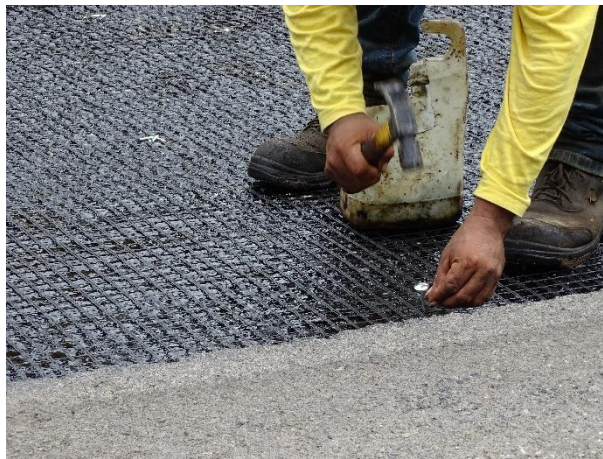
Figura 21 . Anclaje de la geomalla
