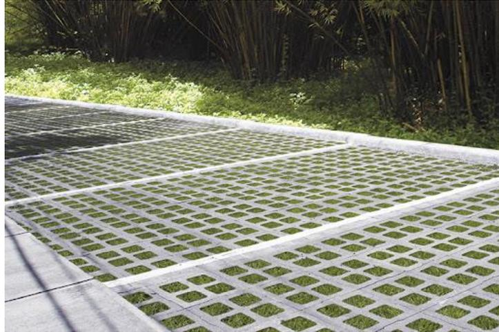
Figura 17. Zacate Block en estacionamiento
