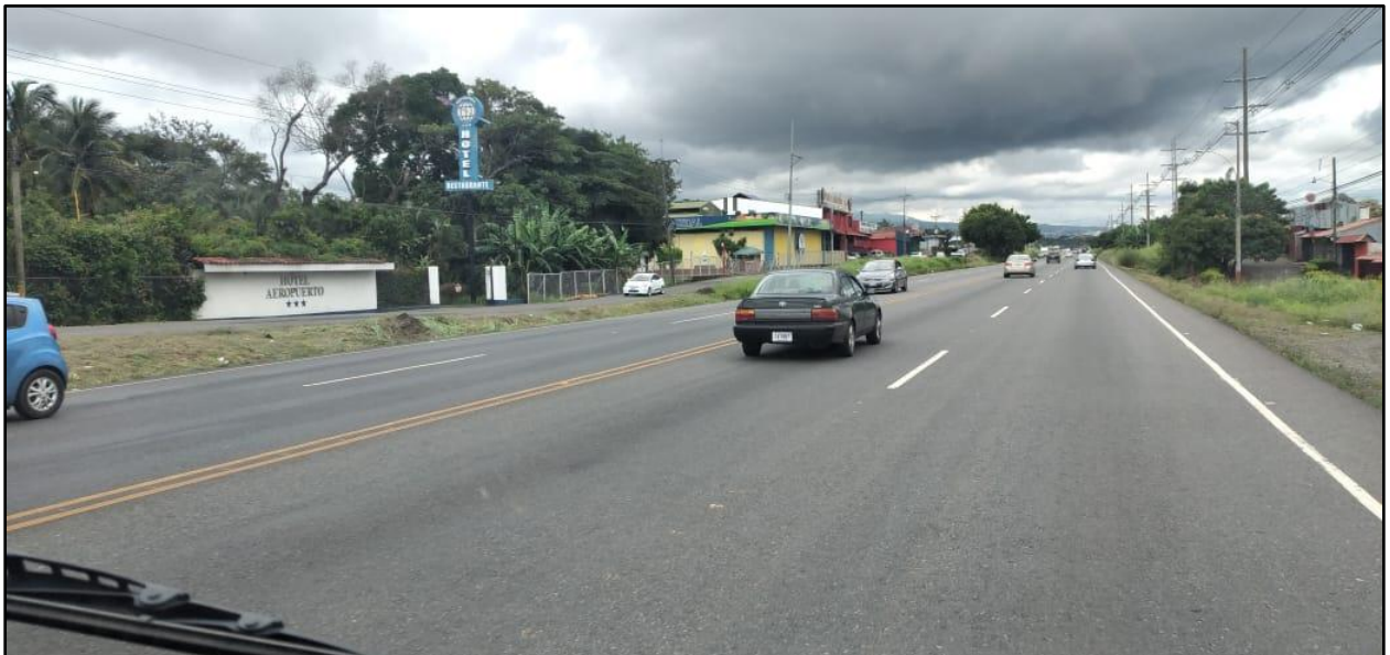
Figura 30. Vista del tramo 1
