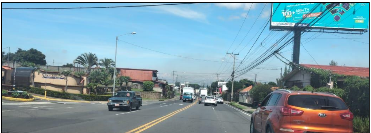
Figura 36. Vista del tramo 4
