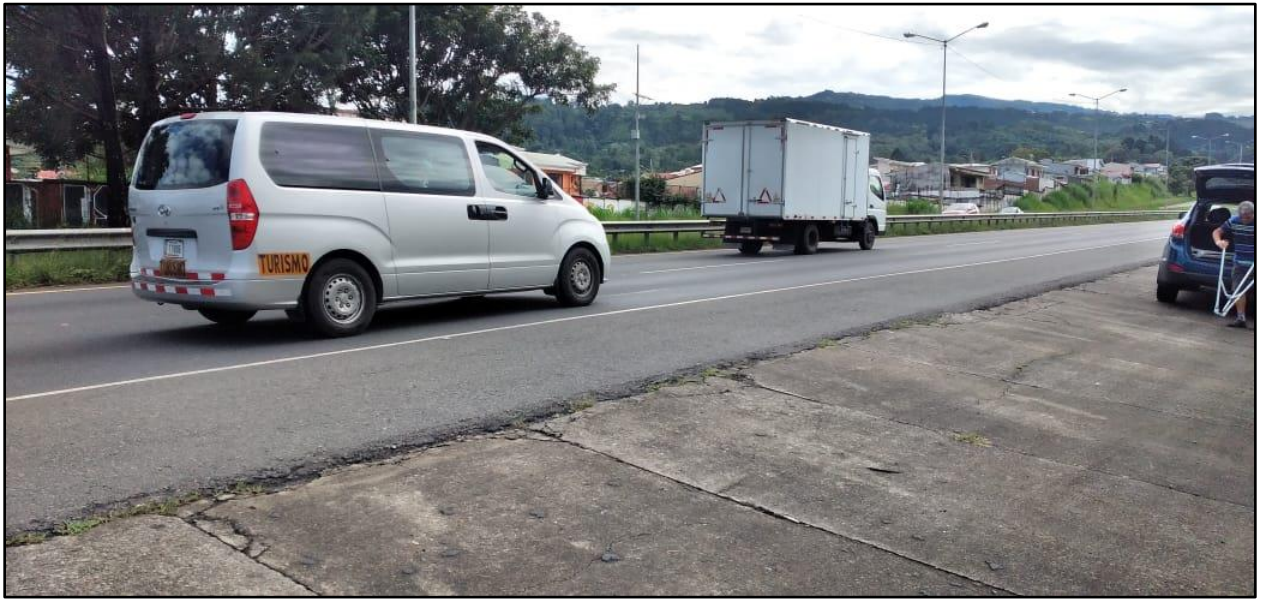
Figura 31. Vista del tramo 2
