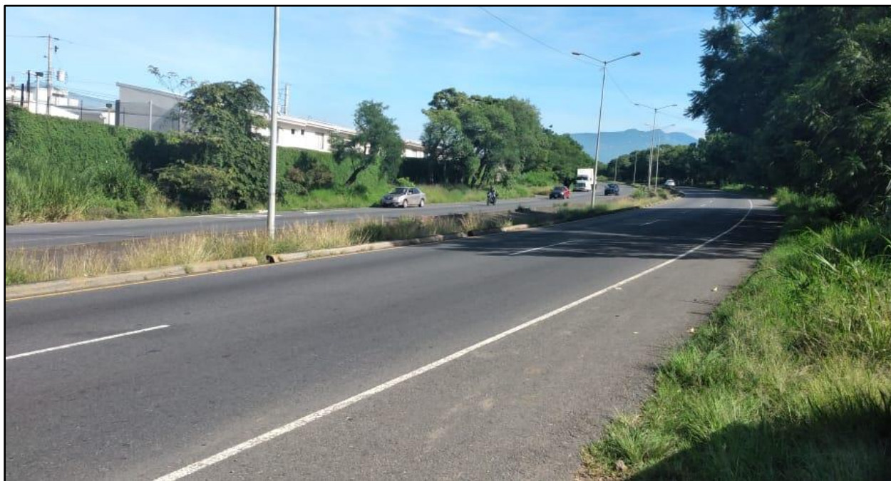
Figura 33. Vista del tramo 3
