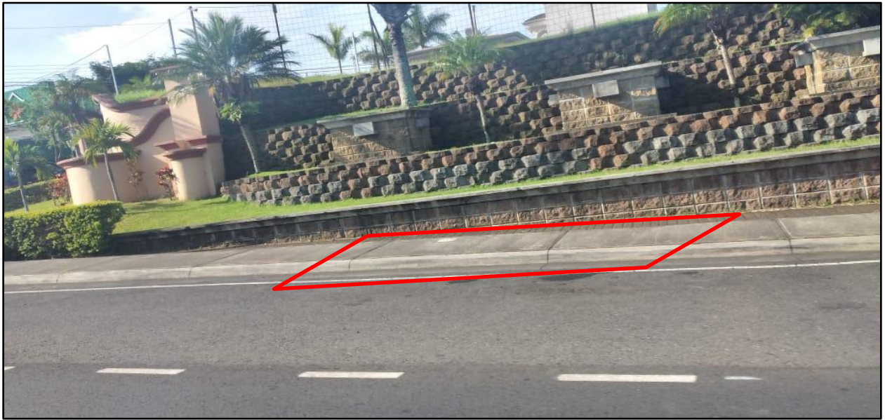
Figura 35. Vista de la estación 4
