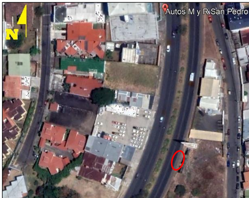
Figura 24. Ubicación del equipo estación 6
