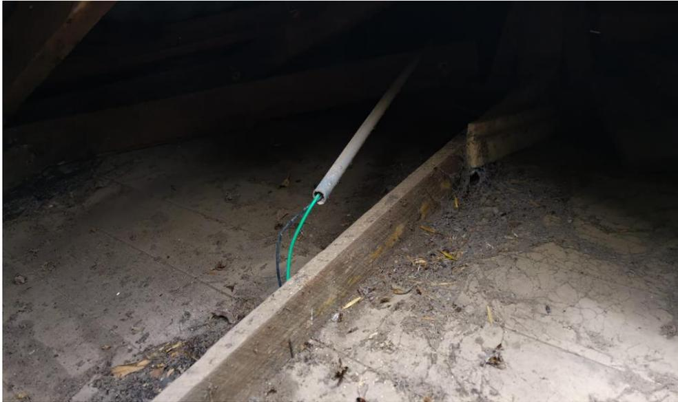
Figura 49. Detalle de salida a lámpara en cielorraso
