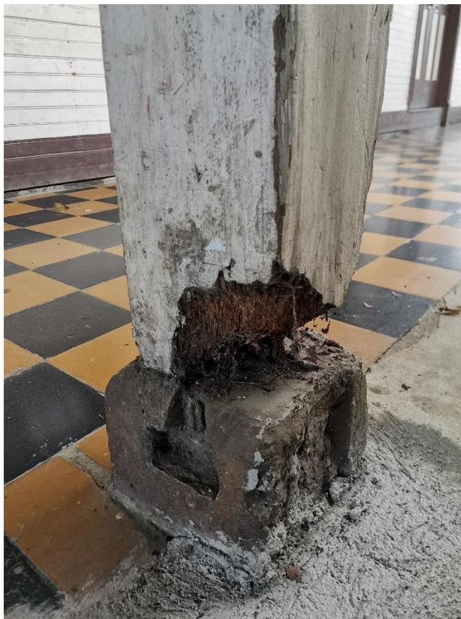
Figura 13. Base de columna deteriorada
