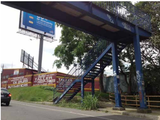
Fig. 9 Puente peatonal en Rotonda de la Bandera Fuente : Fotografía propia (Mayo, 2013)
