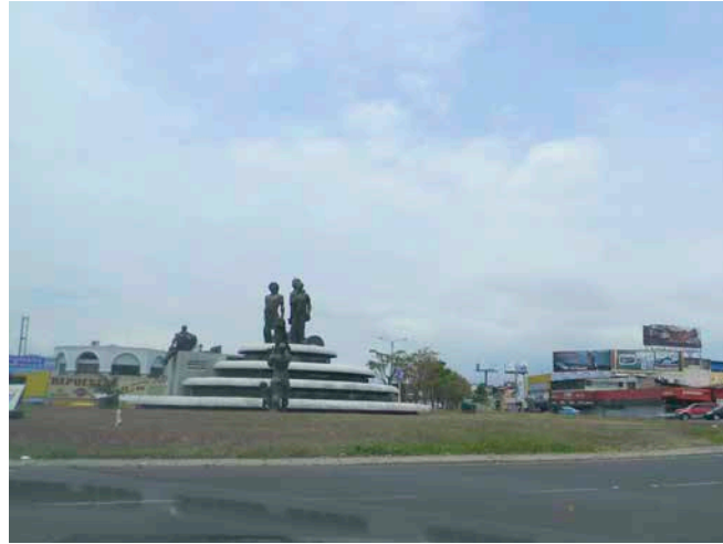
Fig. 6 Rotonda de las Garantías Sociales Fuente : Fotografía propia (Abril, 2012)
