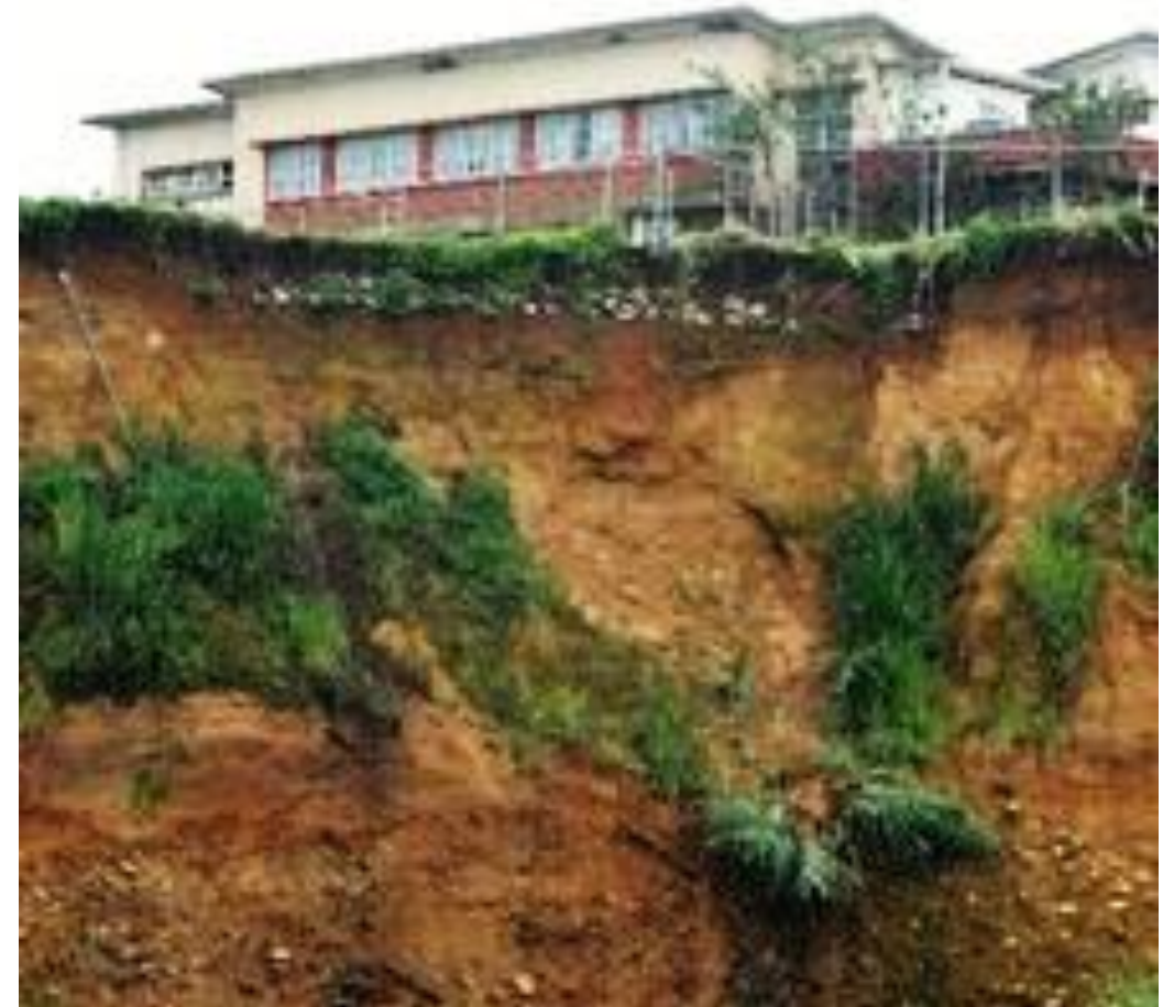
Imagen #40 “Deslizamiento del CAI El Buen Pastor” Fuente electrónica: http://www.nacion.com/sucesos/reclusas-evacuadas-riesgo-Buen-Pastor_0_1207879209.html (2011)
