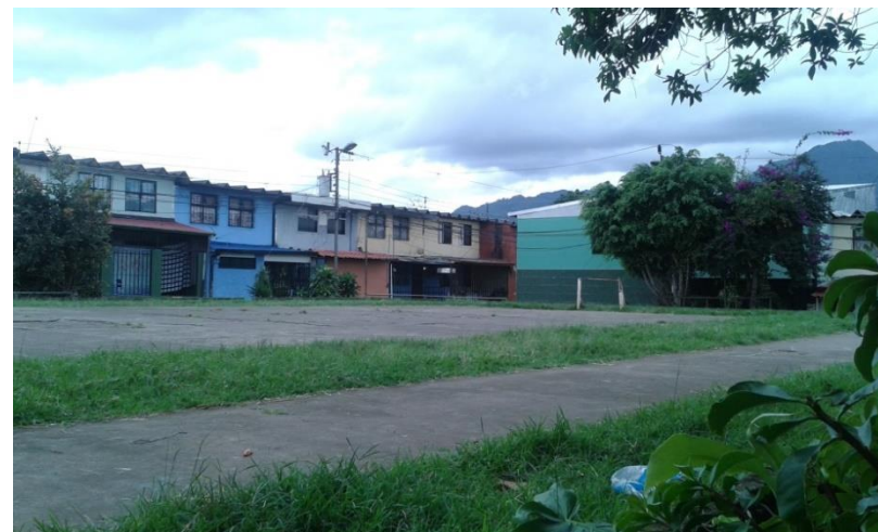
Figura 4: Casas del mismo tipo modificadas por sus dueños durante el tiempo en Hatillo 8 y espacio público. Fotografía del autor, noviembre del 2014.
