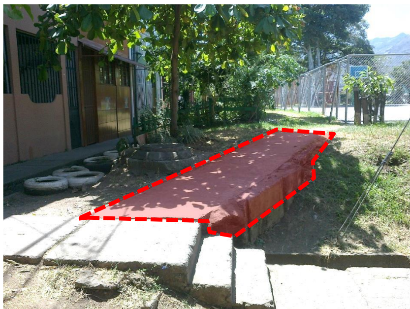
Figura 28: Se muestra la rampa que fue construida para evitar la apropiación del espacio por parte de los jóvenes frente a la casa de Ligia. Fotografía propia, febrero del 2016.
